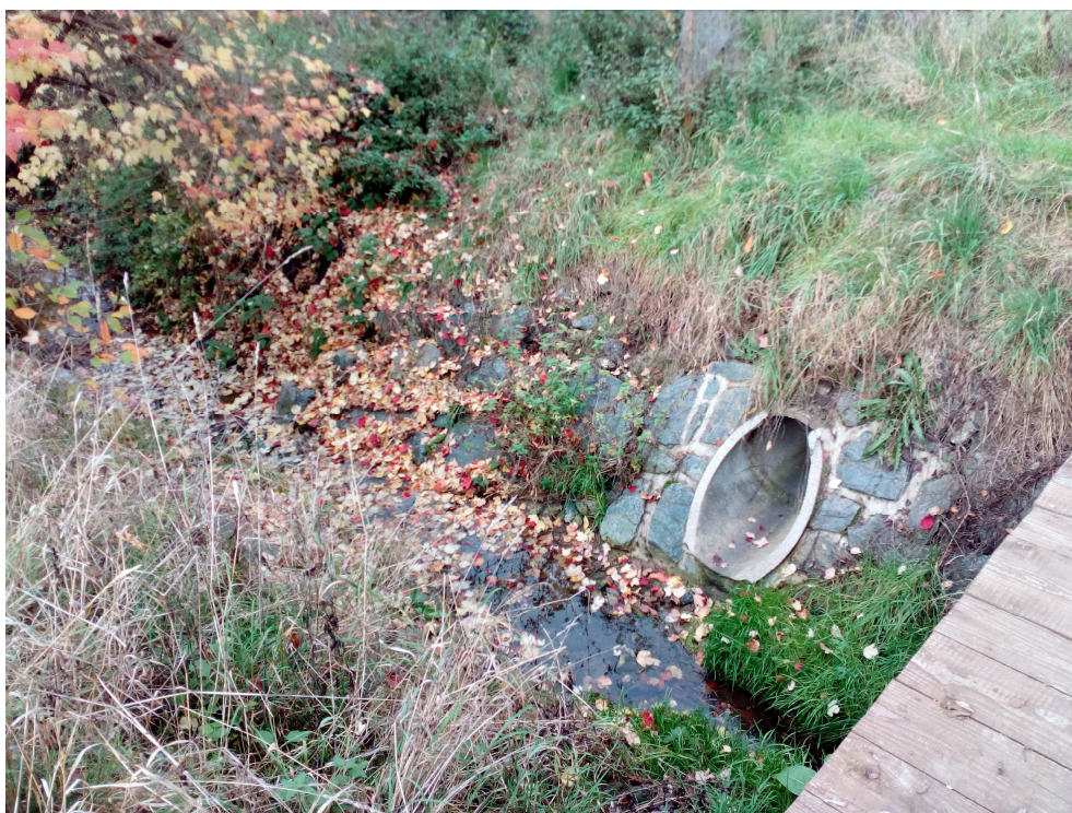
Foto č. 10 Výúst' s opevněním v ř. km 2,006
