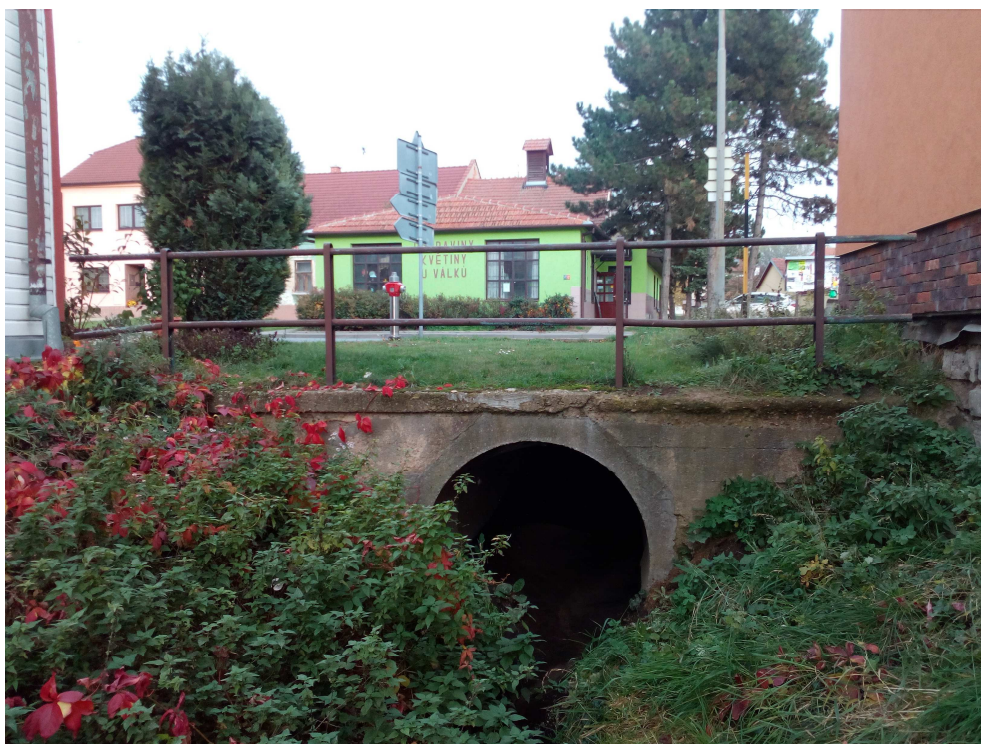
Foto č. 80 Výtokové čelo zatrubňení DN1500 v ř. km 2,536
